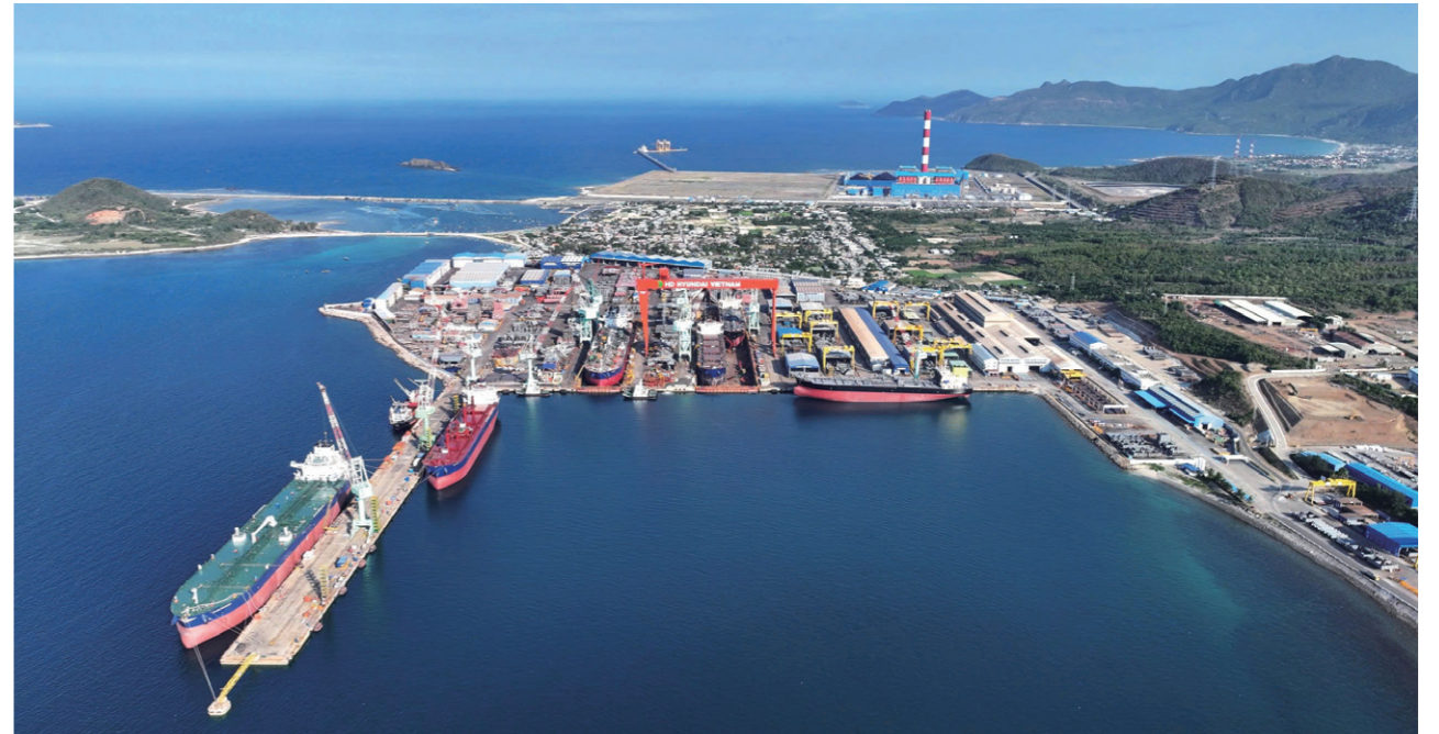
HD현대가 HD현대베트남조선(HVS) 생산능력 확대와 건조 선박 다변화를 본격 추진하며 베트남을 그룹 차원의 핵심 전략 거점으로 육성하고 있다. HD현대베트남조선 칸호아성 공장 전경. 사진=HD현대
